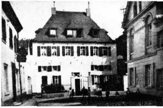
Zur Hinterlassenschaft des Kurstaates gehörte das nach 1689 erbaute Gebäude der „Kurfürstlichen Kellerei“ an der Burgstraße, also der ehemaligen kurfürstlichen Finanzverwaltung. Das Haus gelangte später in den Besitz des Kaufmannes Jakob Fröhlich. Später gehörte es der Rhein. AG für Braunkohle. Es wurde im zweiten Weltkrieg total zerstört.
